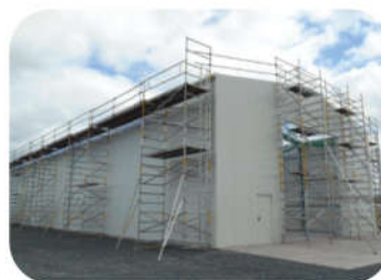
屋顶安装临时脚手架，快速高效。
