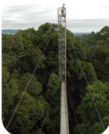
Span系列和铝合金桥架的组合，搭建成一个的观察塔和人行走道。
