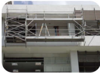
悬吊式脚手架。
